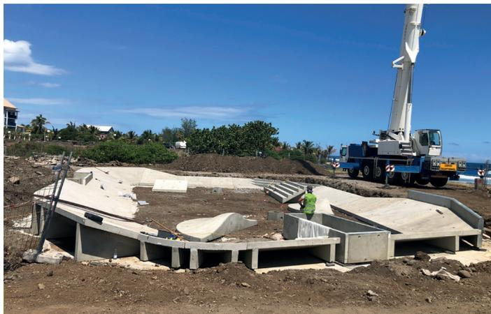
**Un skatepark peut être conçu à partir de béton coulé sur site et d'éléments préfabriqués en usine, comme ici à Saint-Pierre, La Réunion. Avantage : le temps de pose est plus court et l'application du béton n'est pas contrainte par les conditions météorologiques, notamment lorsque les températures sont très élevées.**
